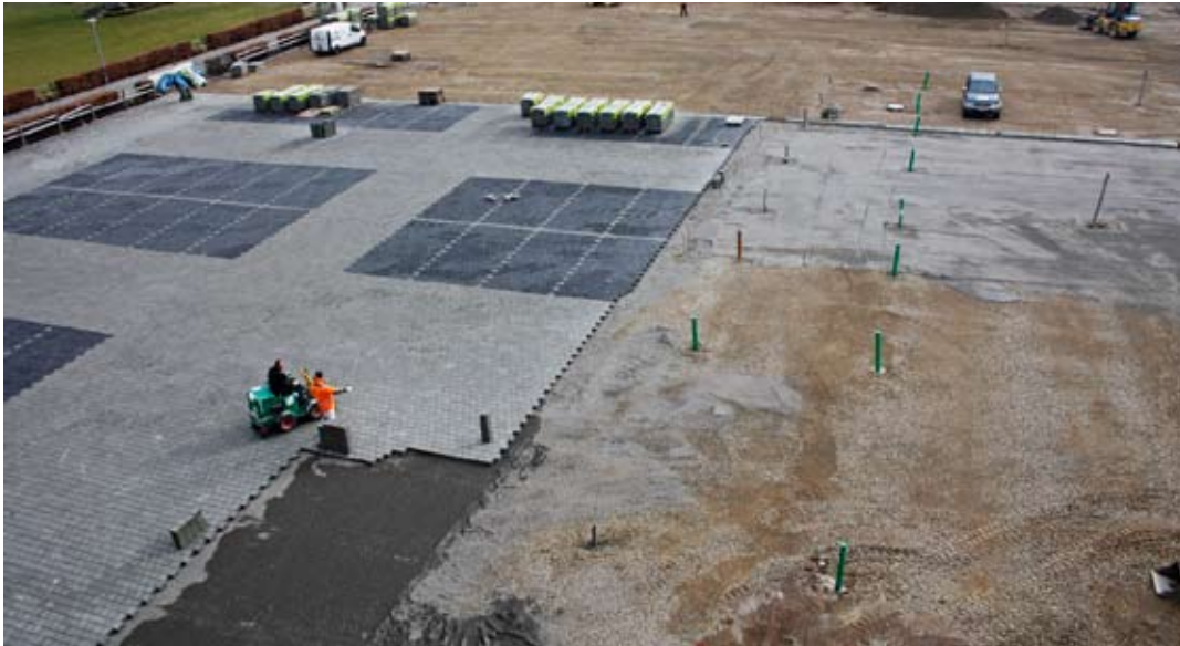
Blick von oben auf den Parkplatz vor der Geschäftsstelle, der derzeit gepflastert wird.
